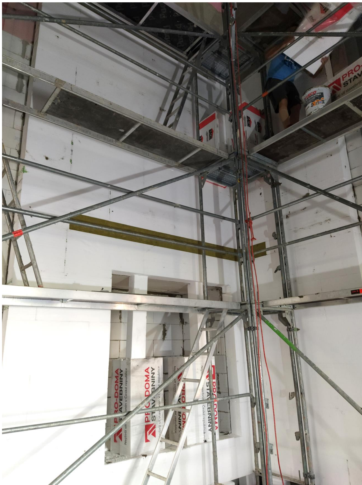
Vzorek po nalepení izolantu z EPS a pruhu z minerální vlny
