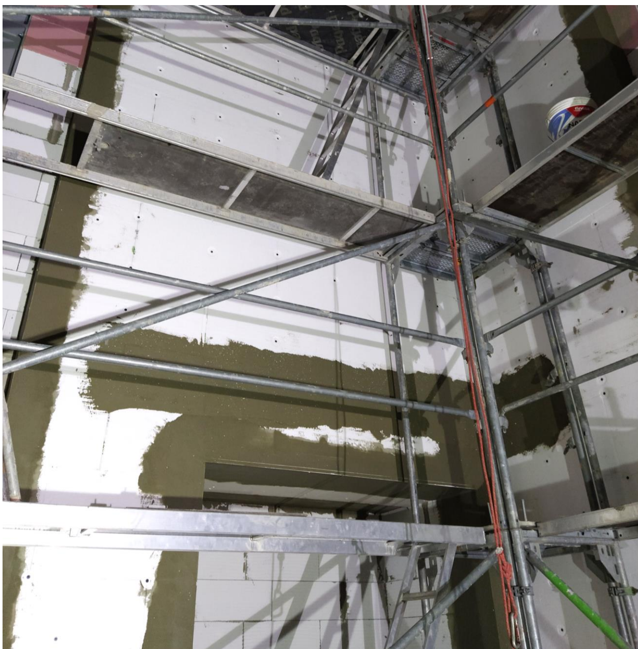
Kotvení izolantu EPS a MW hmoždinkami, provedení zesilujícího vyztužení
